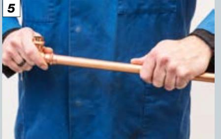
5 Das Rohr unter leichten drehen bis zum markierten Anschlag in den Fitting schieben
