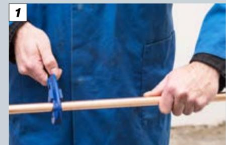
1 Kupferrohr mit Rohrschneider ablängen (alternativ mit feinzahniger Metallsäge)
